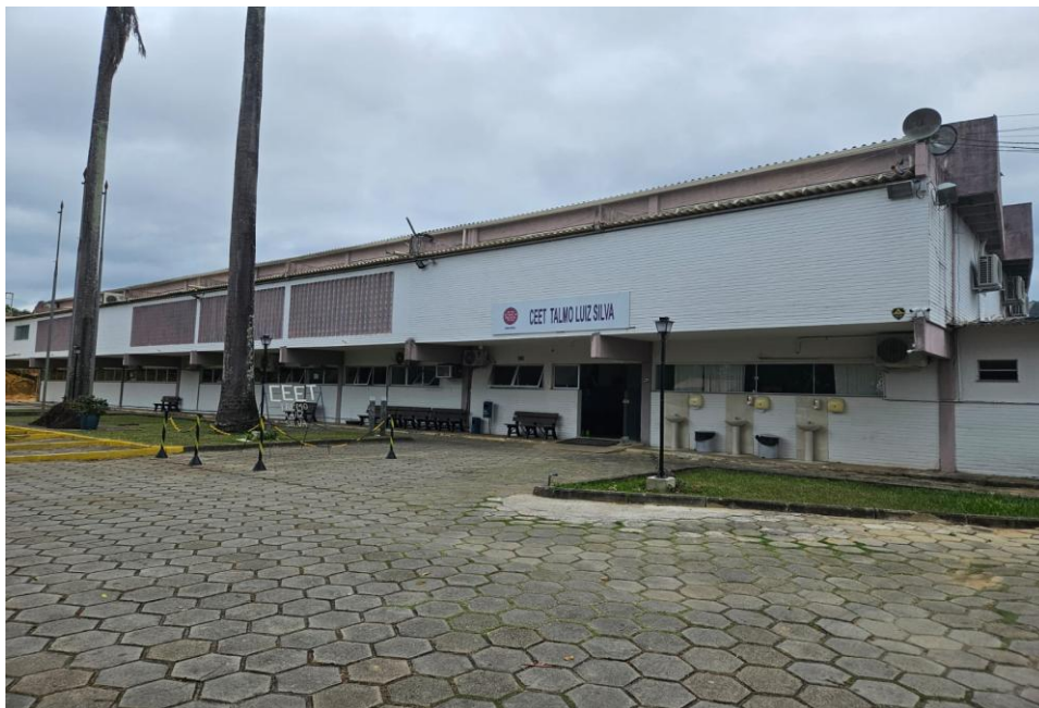
Foto externa do prédio escolar
