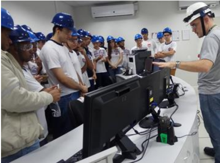
Sala de controle – Usina Hidrelétrica Mascarenhas – 2017
