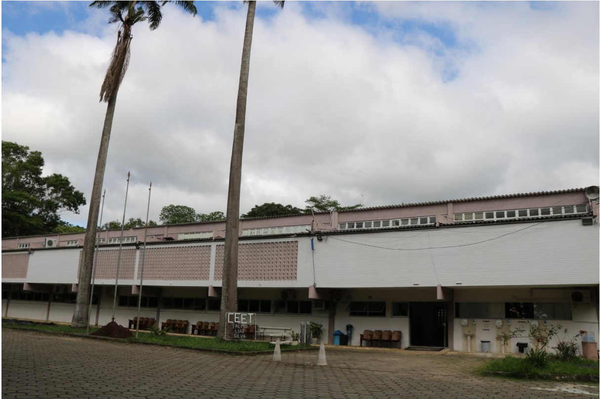
Foto 1 - Foto externa do prédio escolar
