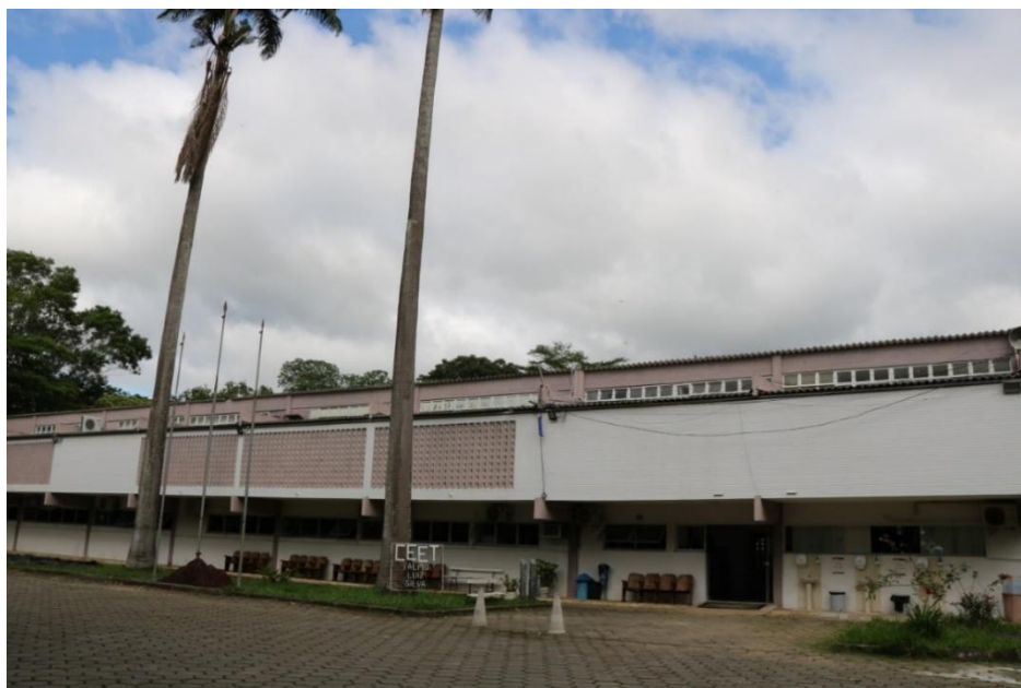
Figura 45 - Foto externa do prédio escolar
