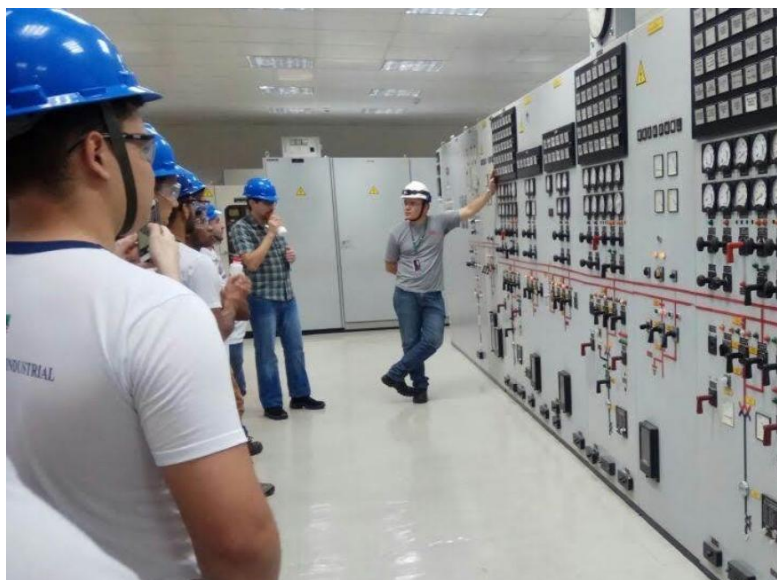
Figura 3 - Painel de controle – Usina Hidrelétrica Mascarenhas - 2017
