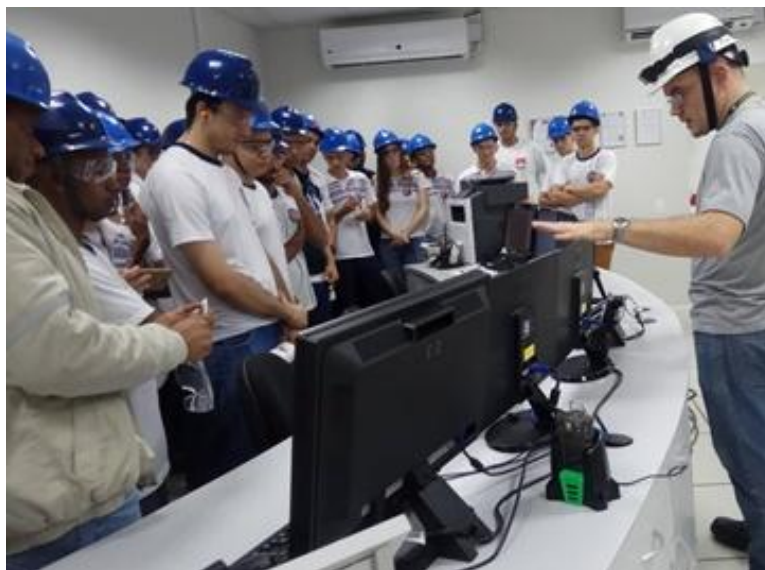
Figura 2 - Sala de controle – Usina Hidrelétrica Mascarenhas - 2017
